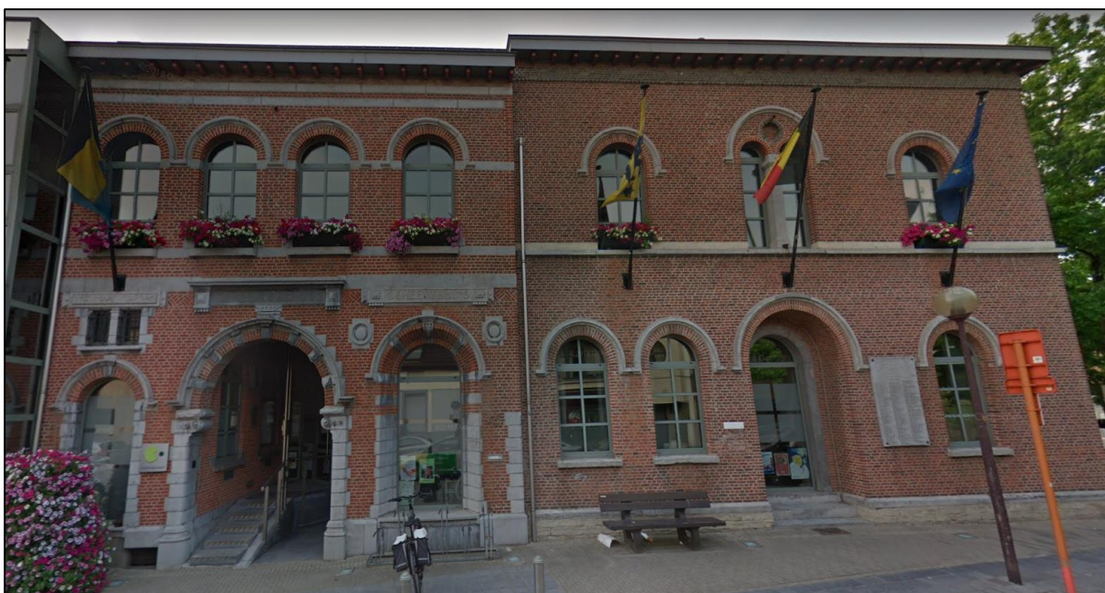
Figuur 7: zicht op het voormalige gemeentehuis langs de oostelijke zijde van het studiegebied (Google Maps 2020)
