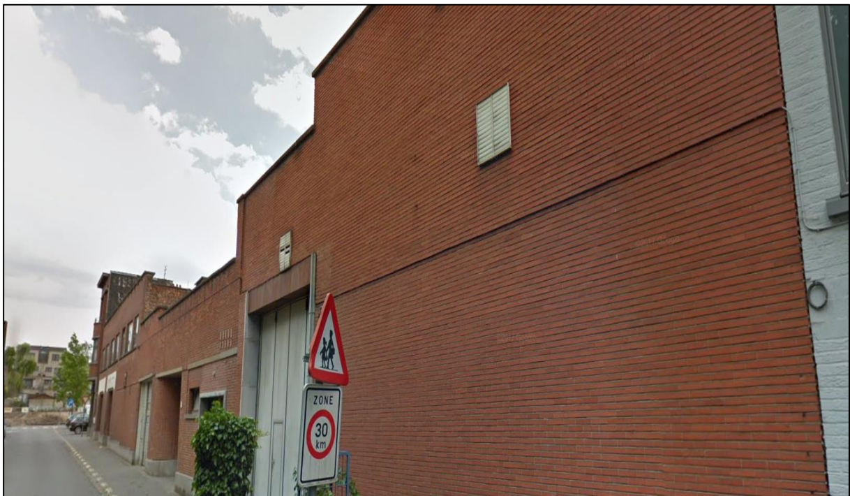
Figuur 10: Zicht op de schoolgebouwen aan de noordelijke zijde van het studiegebied (Google Maps 2020)
