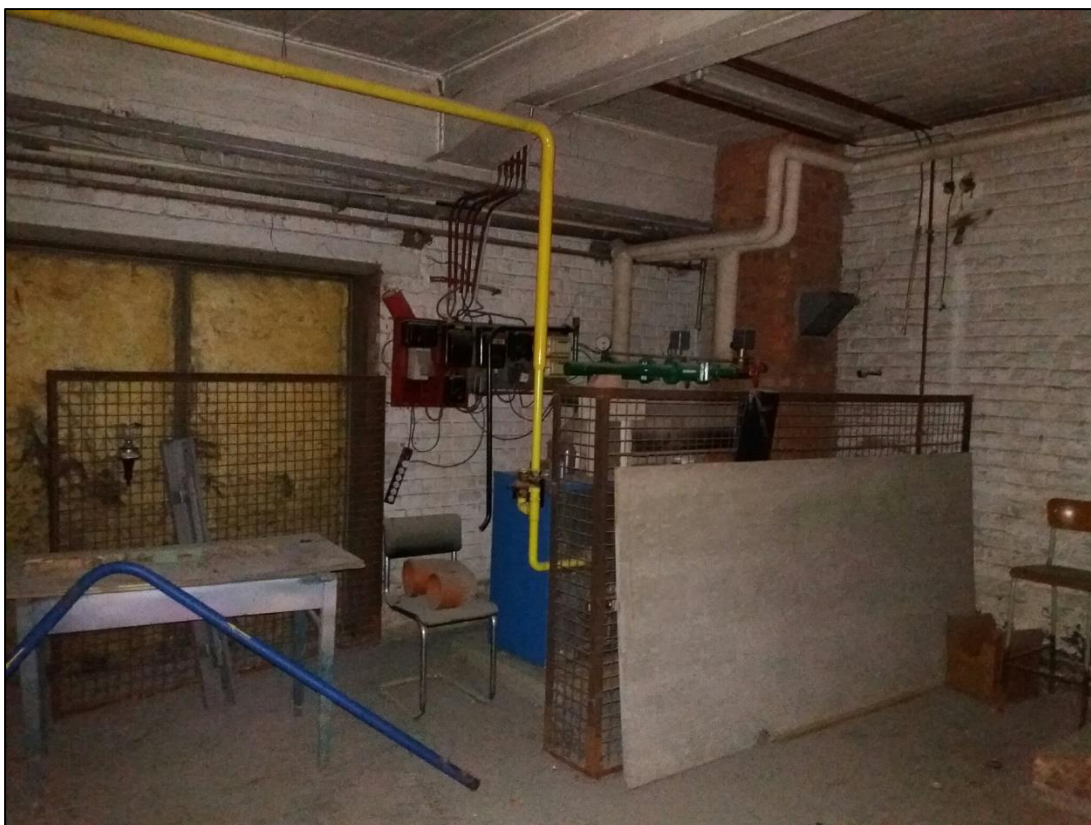
Figuur 11: De kelder ten oosten van de sporthal (ABO nv 2020)
