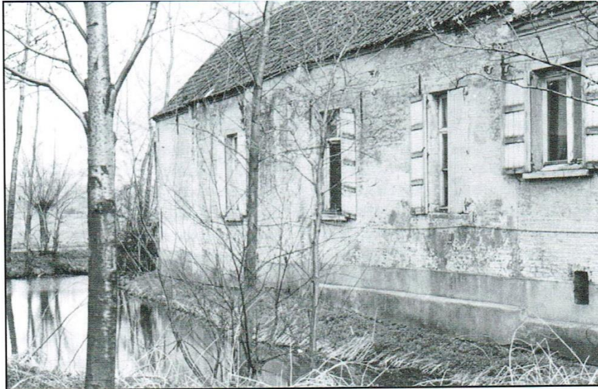
Figuur 32: Zicht op de buitenzijde van het Echelpoelhof met gracht. (D. Binon 2002: p. 53)
