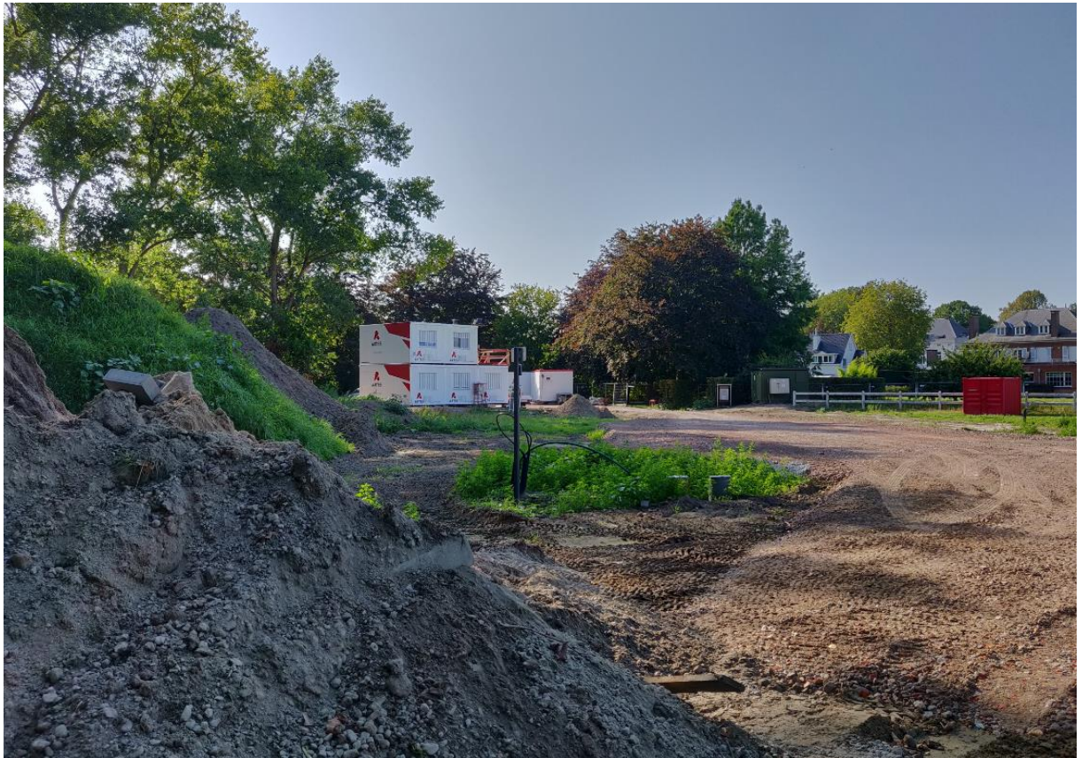
Figuur 6: Huidige toestand van het terrein (bron: opdrachtgever).
