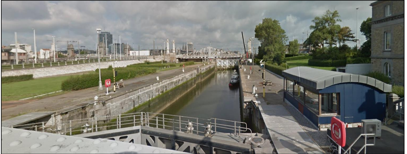
Figuur 4: Zicht op de Demeysluis vanaf het zuiden (Google Maps 2020)
