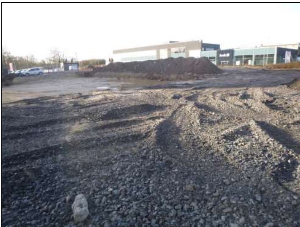
Figuur 13: Foto van de gesaneerde oostelijke zone (ABO nv 2020)
