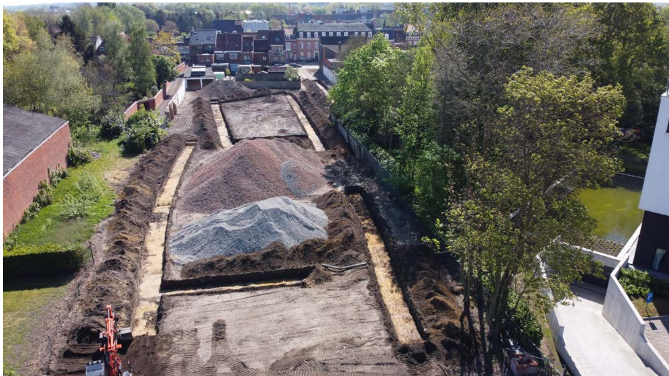
Figuur 10: Zicht op de uitgevoerde sleuven en de aanwezige steenpuinhopen
