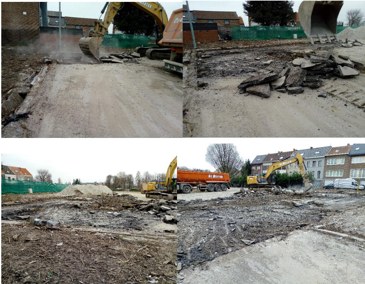
Figuur 14. Zicht op aanwezige nutsleidingen en putten tussen de sleuven ter hoogte van het voormalige gebouw
