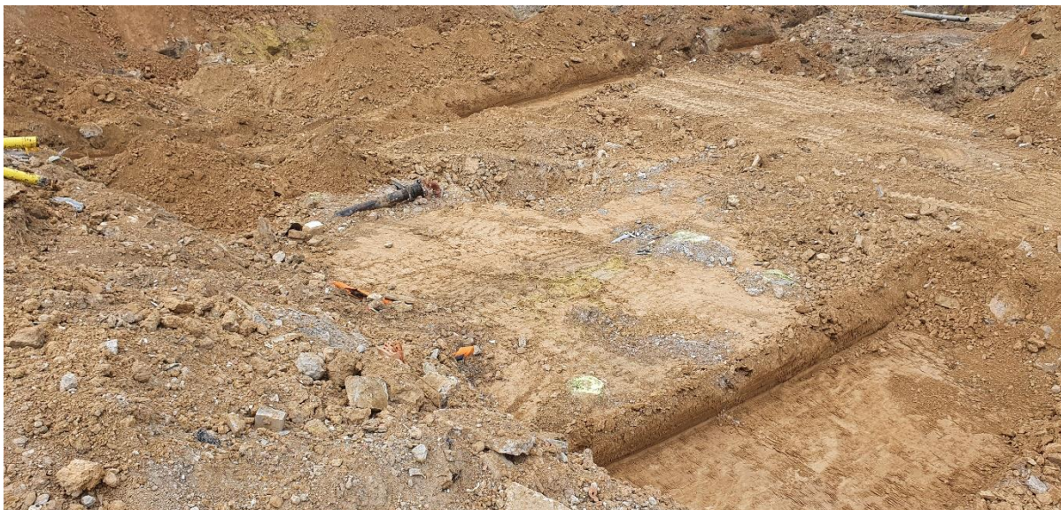
Figuur 15. Zicht op aanwezige nutsleidingen en putten tussen de sleuven ter hoogte van het voormalige gebouw
