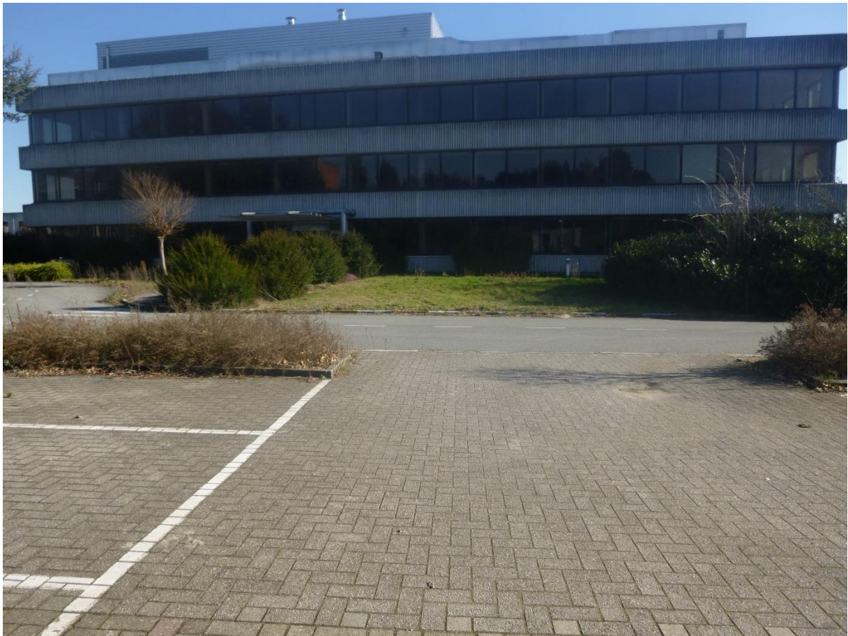
Figuur 12: Omgevingsfoto ter hoogte van boorpunt BP7 in oostelijke richting.
