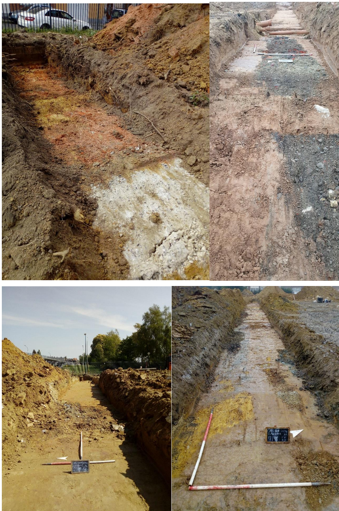
Figuur 25. Zicht op verstoringen in sleuven
