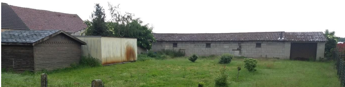
Figuur 7: Noordoost georiënteerd bijgebouw, tuinhuis en garagebox ten oosten van het hoofdgebouw (foto 7) (aangeleverd door de initiatiefnemer)
