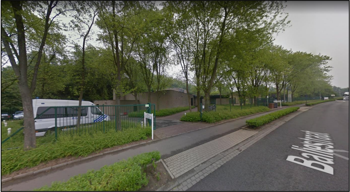
Figuur 3 Zicht op de bebouwing vanaf de Baliestraat, vanuit het noordwesten (bron: www.googlemaps.be ).
