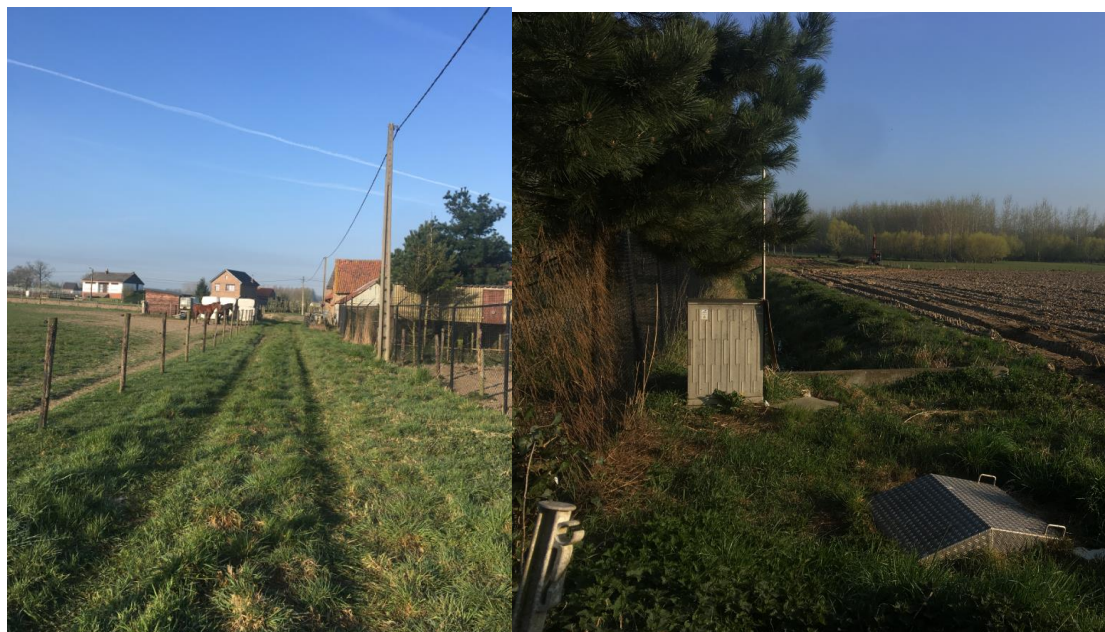
Figuur 21: Leiding in de inrit en verschillende koppelkasten aan de hoek van het terrein (bron: ABO nv 2020)
