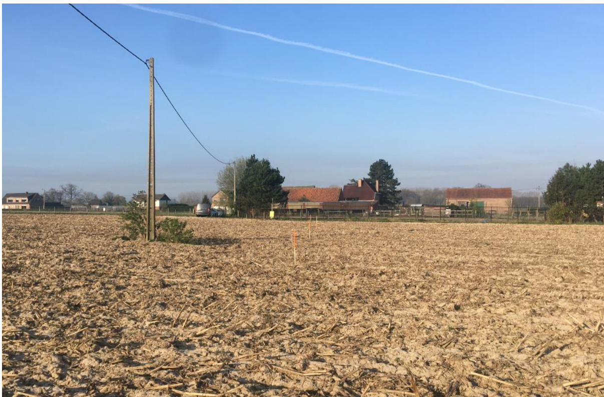
Figuur 22: Uiteindes van de werkputten (jalons) en de leiding (bron: ABO nv 2020)
