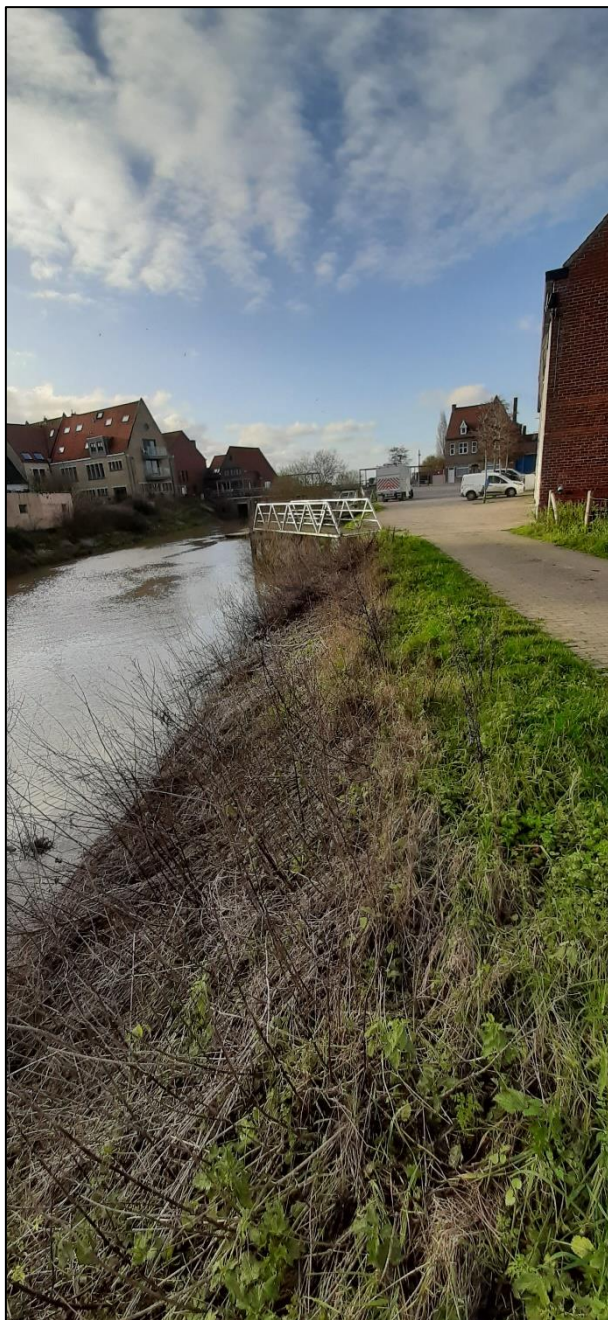
Figuur 18: Locatie waar slipway aangelegd zal worden 24
