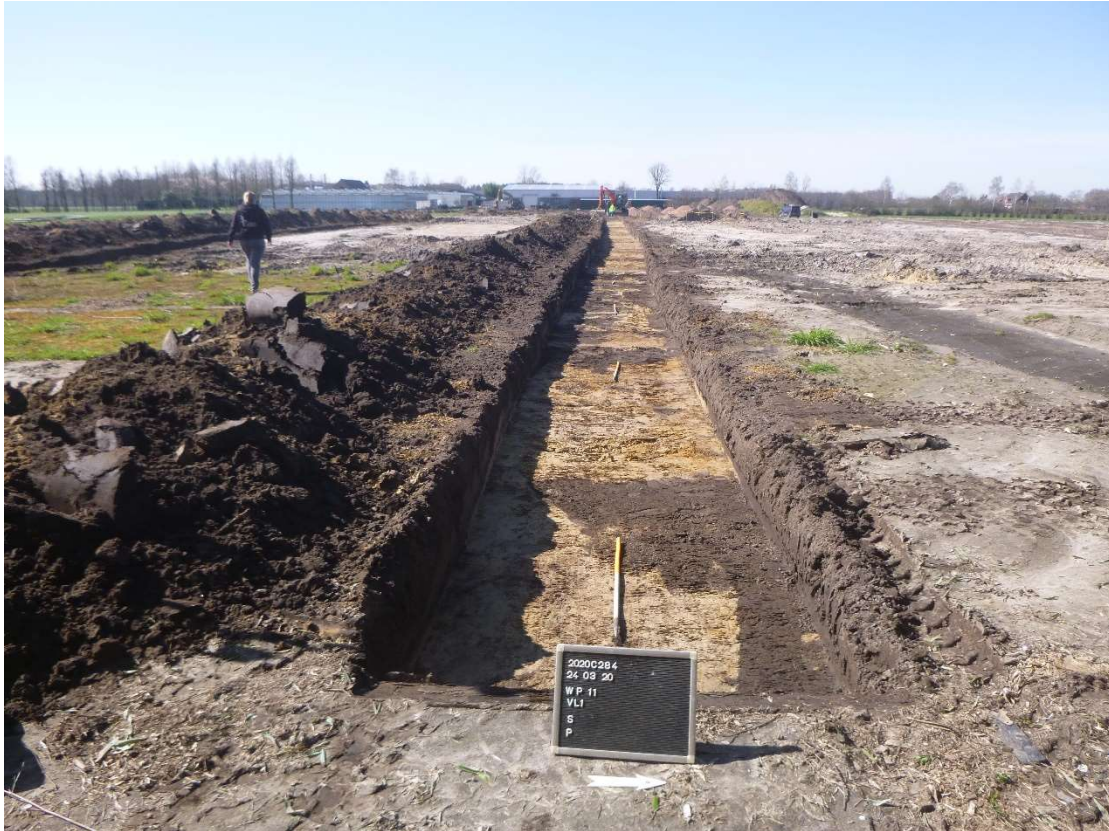
Figuur 34. Werkput 11 (oostelijk deel van de sleuf in het oostelijke deel van het plangebied). ©LARES
