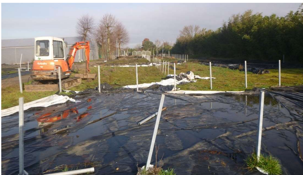
Figuur 14d. Zicht vanuit het zuiden op de bedden aan de oostkant van het plangebied. ©LARES
