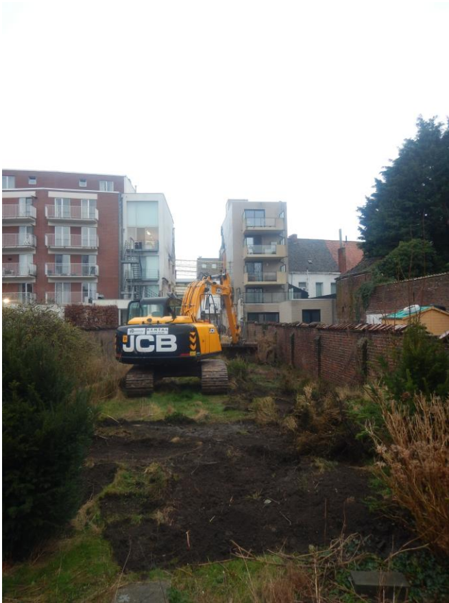
Figuur 13 Locatie van werkput 1 voor de start van de graafwerken.
