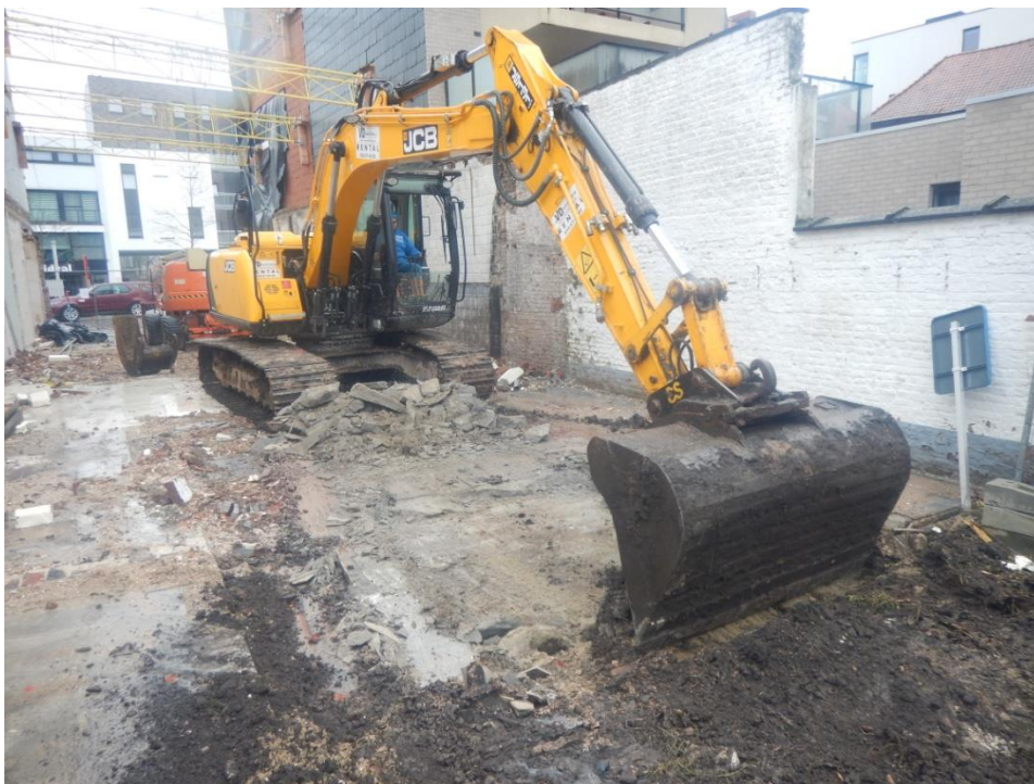
Figuur 14 Locatie van werkput 3 net voor de start van de graafwerken.
