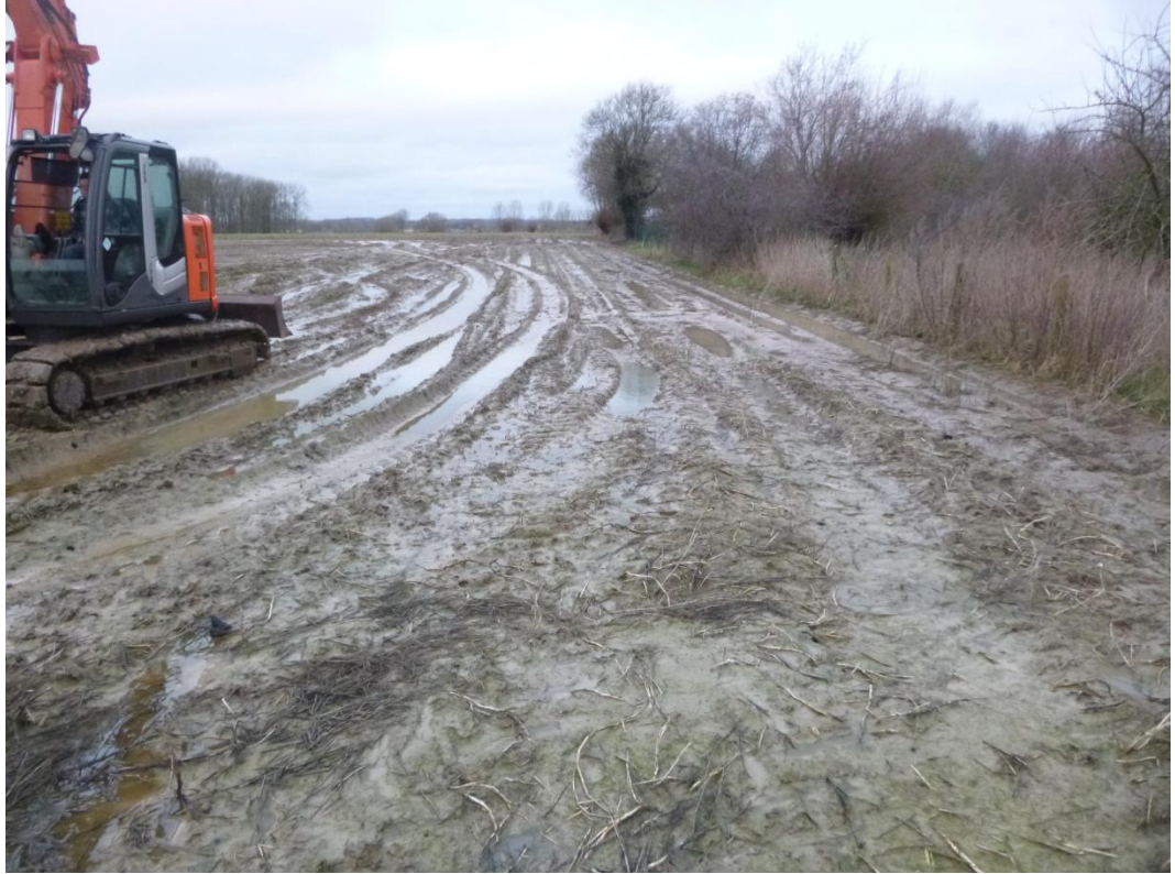
Afb. 22. Zicht op het terrein richting het noordoosten.
