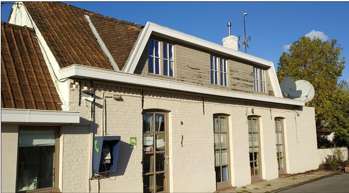
Figuur 26: Oostelijk deel van het gebouw.
