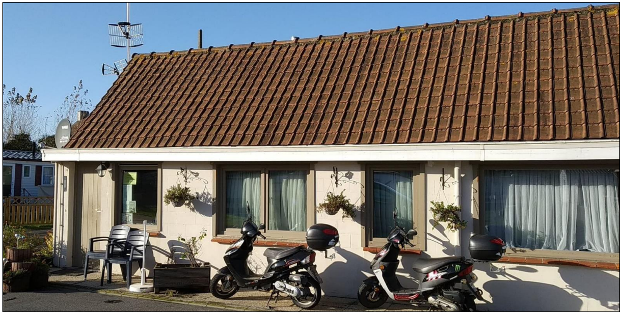
Figuur 27: westelijk deel van het gebouw.
