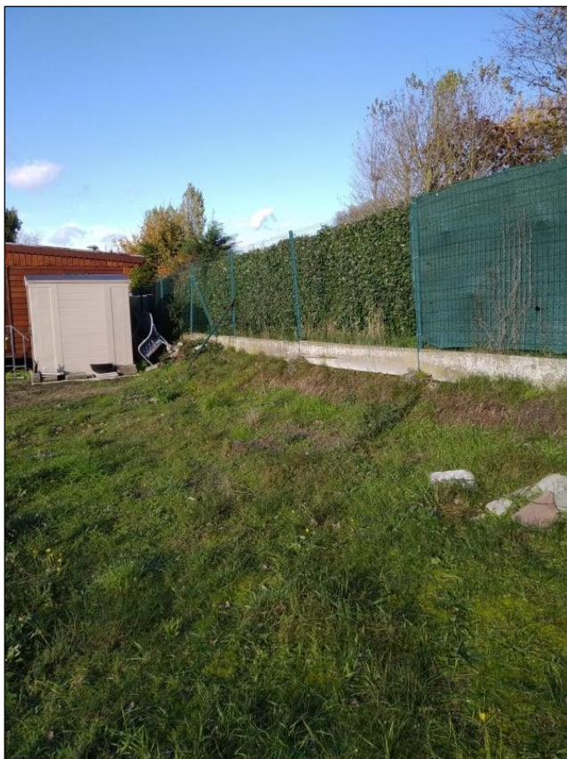
Figuur 41: Hoogteverschil tussen de kampeergelegenheid en de belendende percelen ten oosten (plaatsbezoek).
