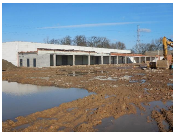
Figuur 14: Uitbraak betonnen vloerplaten (ARCHEBO bvba, 2020)
