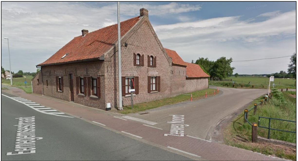
Figuur 6: Vooraanzicht bestaande toestand (Bron: Google Street View).
