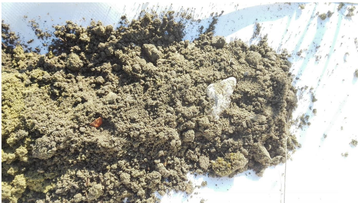
Figuur 35: Een detailfoto van de aangetroffen beton en baksteen in boring 6 (ABO nv 2020).
