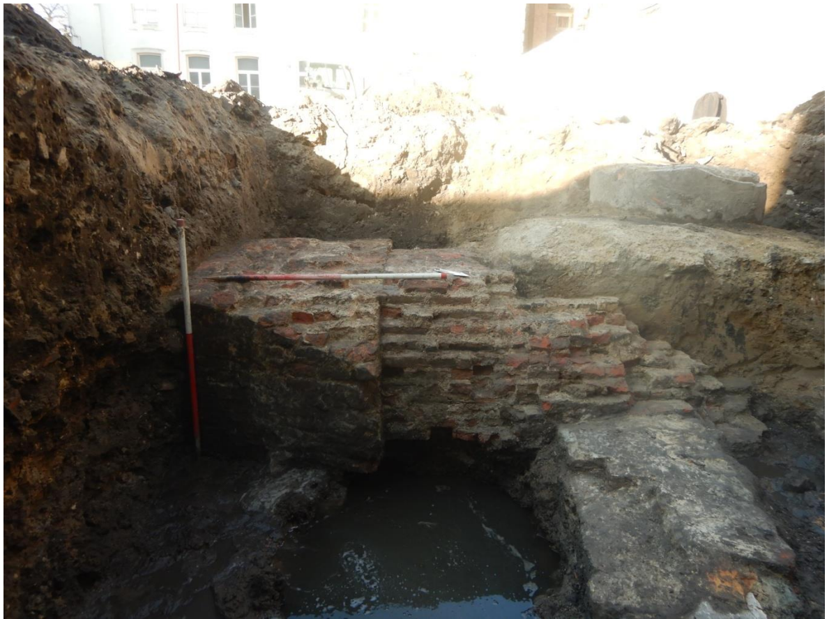
Figuur 46 Aan de linkerkzijde S1, rechts S2 en de betonnen pijler. Vooraan rechts bevindt zich S5.
