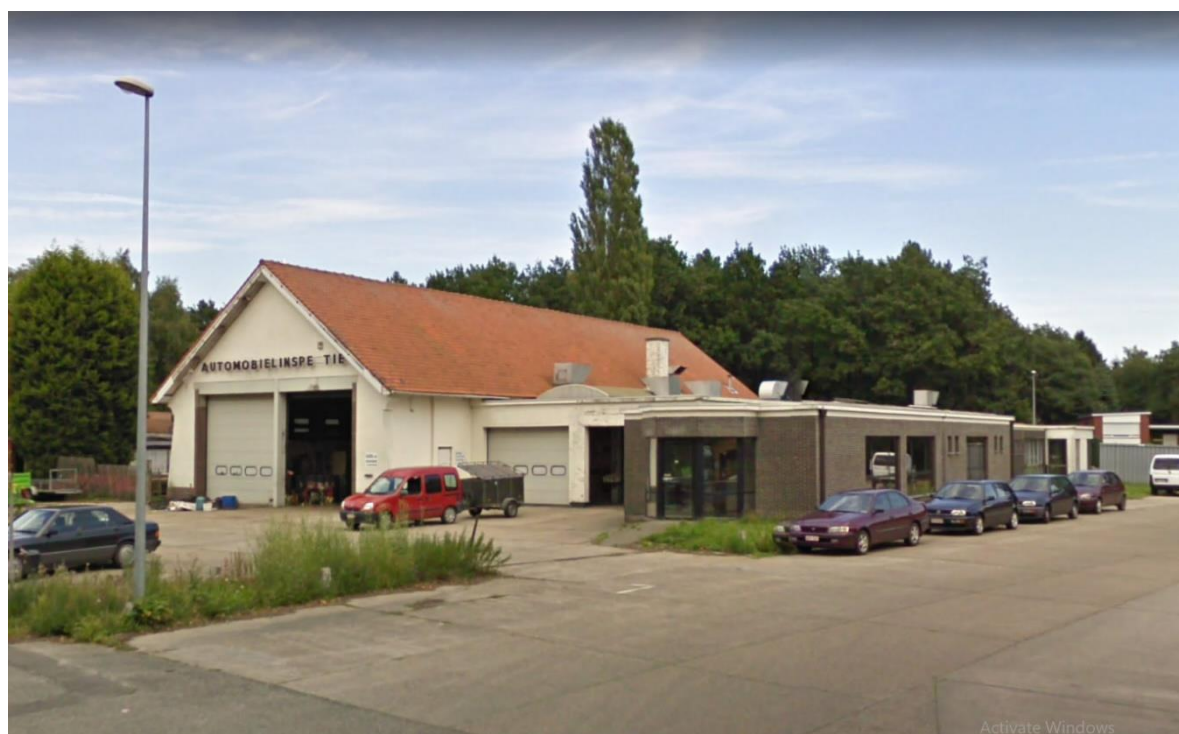
Figuur 4: Plangebied gezien vanuit het zuidwesten 6
