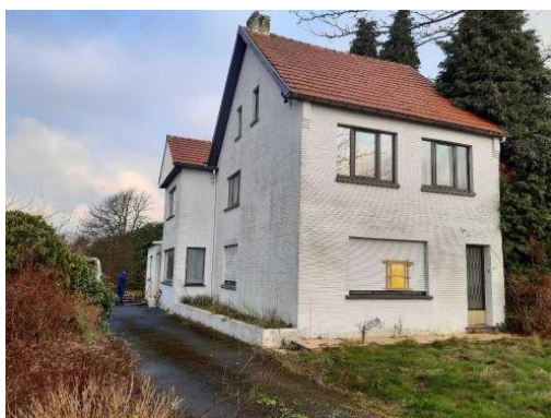
Figuur 4: Voor- en westelijke zijgevel van de woning aan Staatsbaan 94. (ABO nv, 18/02/2020)
