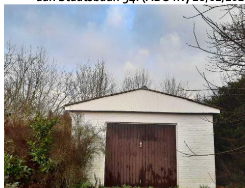
Figuur 7: Voorgevel van de losstaande garage. (ABO nv, 18/02/2020)
