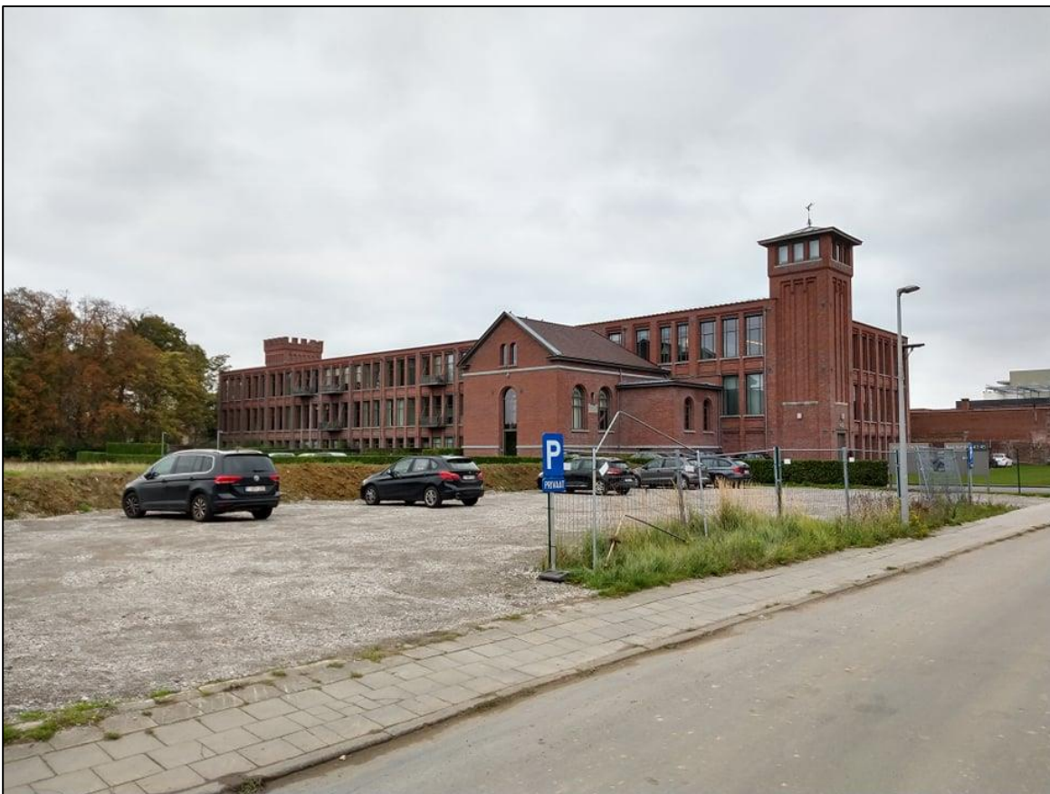
Figuur 6: Bestaande toestand (Bron: opdrachtgever).
