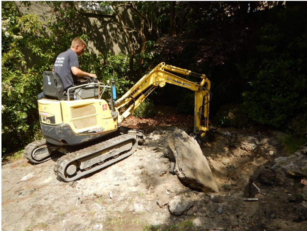
Figuur 6: fotografische opname van de aanleg van werkput 2
