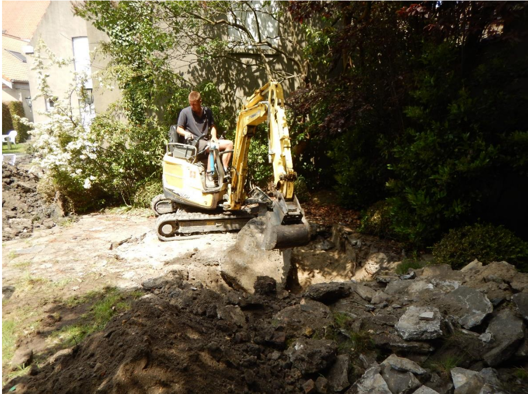
Figuur 24: fotografische opname van de aanleg van werkput 2 en het uitbreken van de stabilisatielagen
