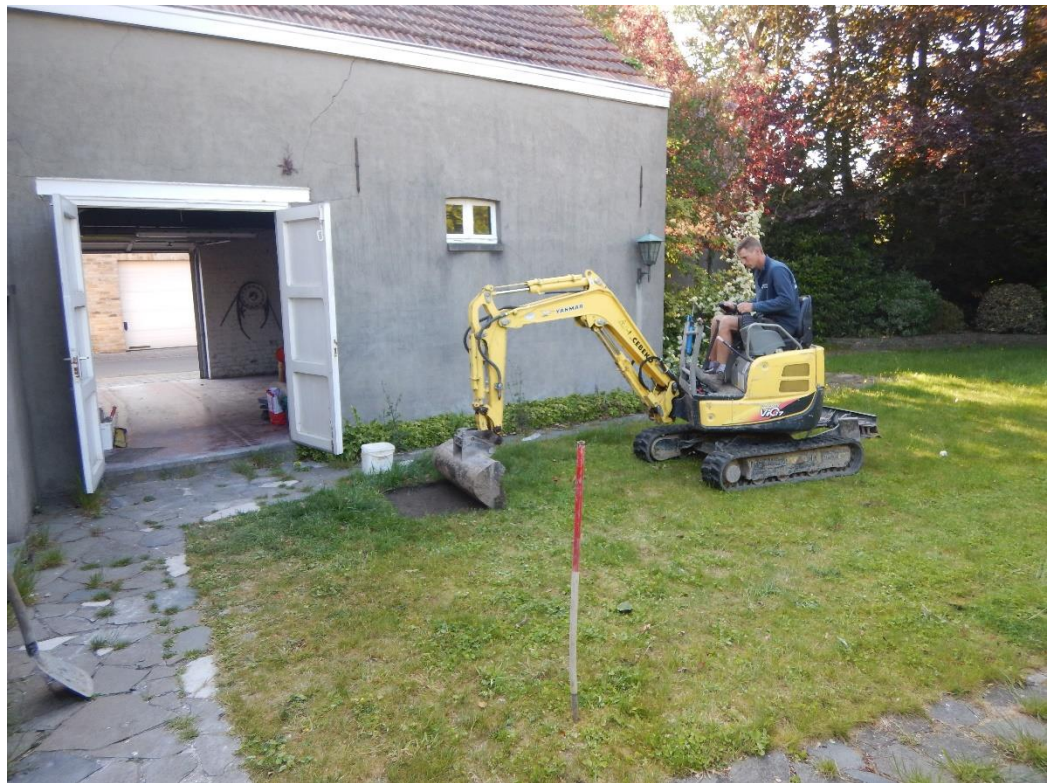
Figuur 5: fotografische opname van de aanleg van werkput 1
