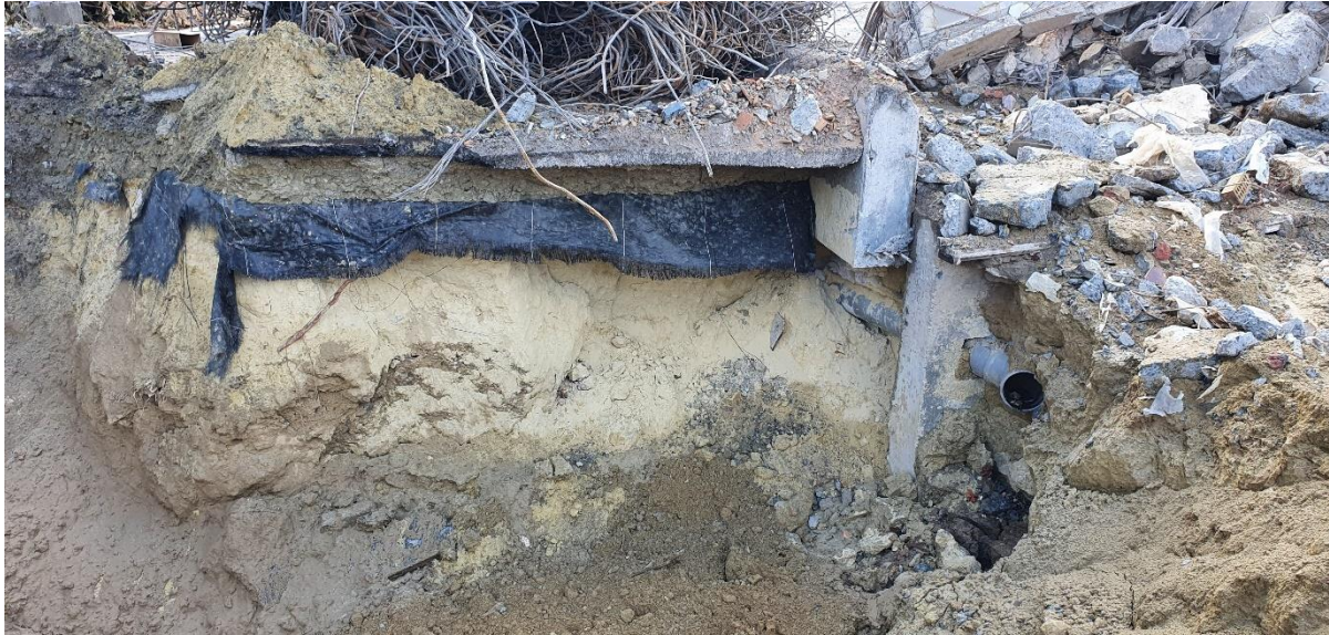
Figuur 7. Profielpit 3 werd stopgezet wegens inkalving
