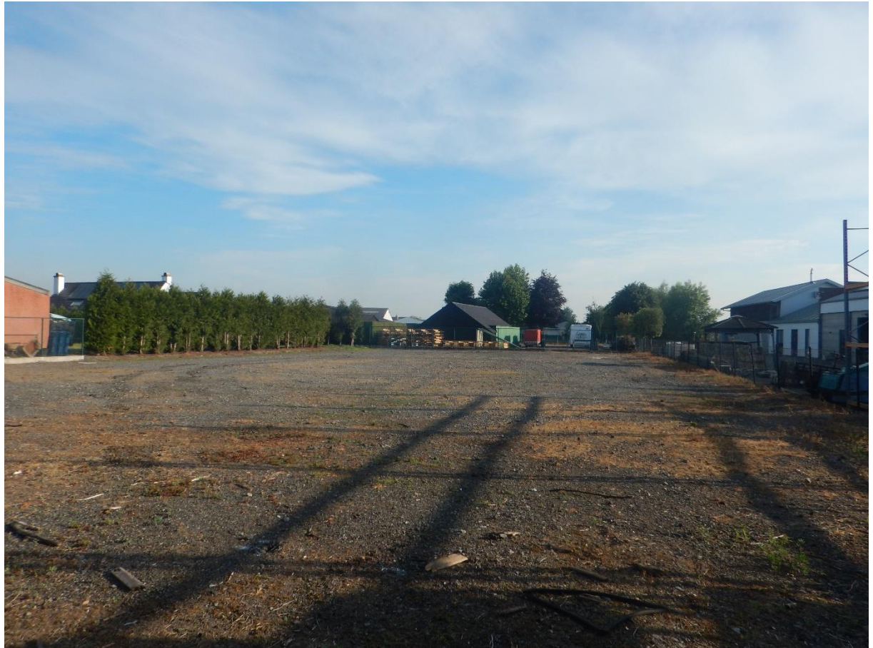
Figuur 7.: Overzicht van het oostelijke perceel, zicht naar het noorden.
