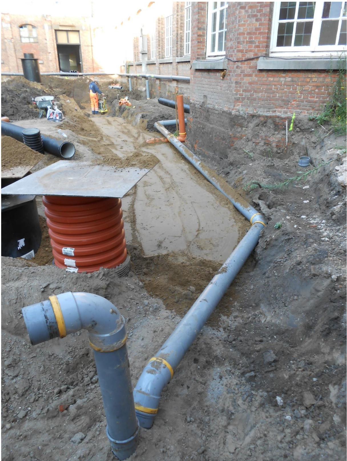
Fig. 3. Zicht op de aanleg van de riolering (foto Interwaas).
