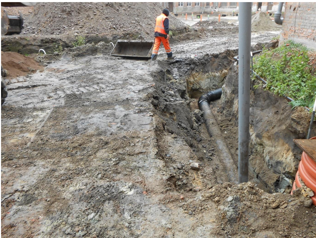
Fig. 4. Aanleg van de riolering aan de hoek van het plein aan het Onze-Lieve-Vrouwplein (foto Interwaas).
