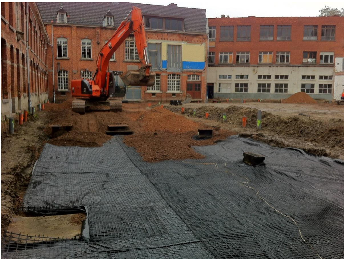
Fig. 7. Zicht op de aanleg van de steenslagverharding (foto Interwaas).
