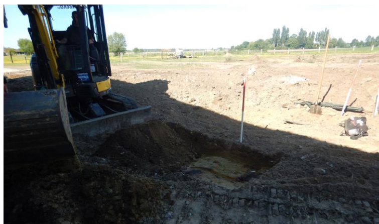
Figuur 7. Sfeerbeelden van de aanleg van een landschappelijke profielput, in voorbereiding van een landschappelijke boring.
