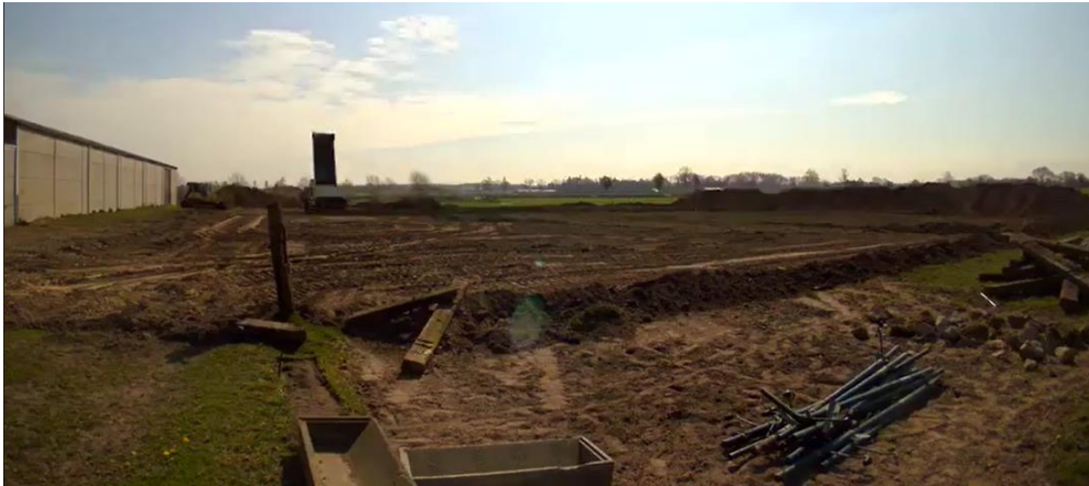
Figuur 32. Profiel 15 in werkput 22. Onder: sfeerbeeld van de aanleg van de piste (april 2020 – bron: Facebookpagina White & Moore Stables).
