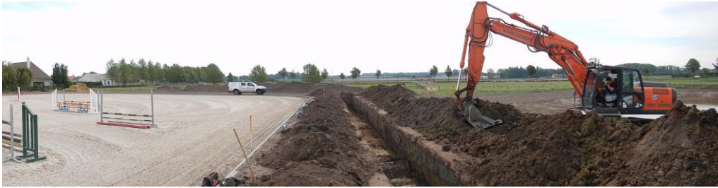
Figuur 24. Sfeerbeelden tijdens het aanleggen van de proefsleuven.
