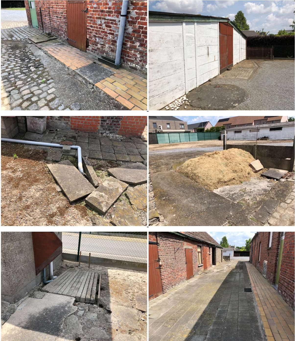
Figuur 9: diverse (regen?)putten naast de opstaande gebouwen (bron: initiatiefnemer verkaveling)
