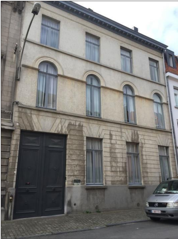
Figuur 31: Kasteelstraat 7, te slopen
