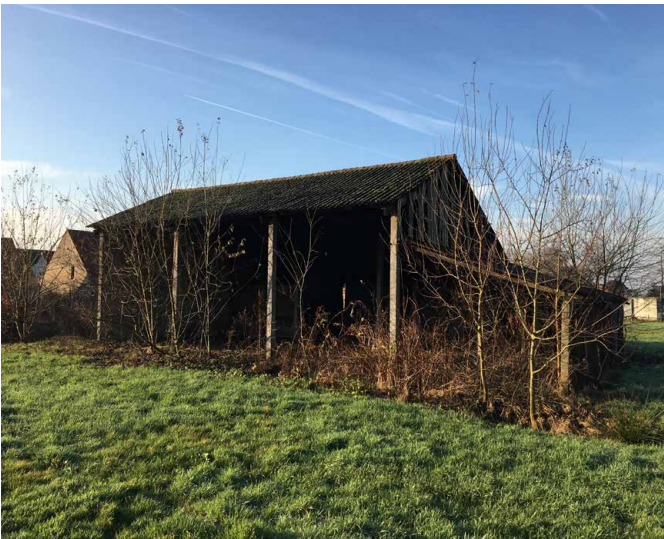
Figuur 15: Zicht op zone A vanuit het zuiden (3)
