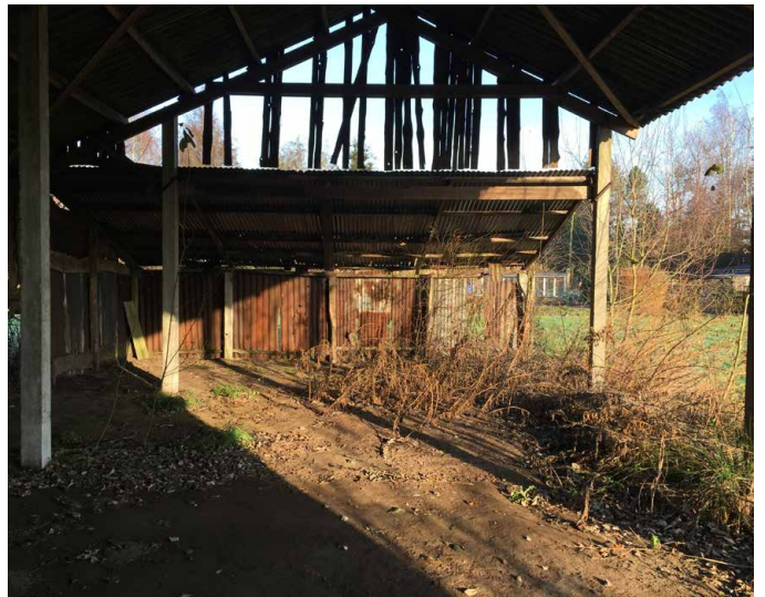
Figuur 16: Zicht op zone A vanuit het zuiden (4)
