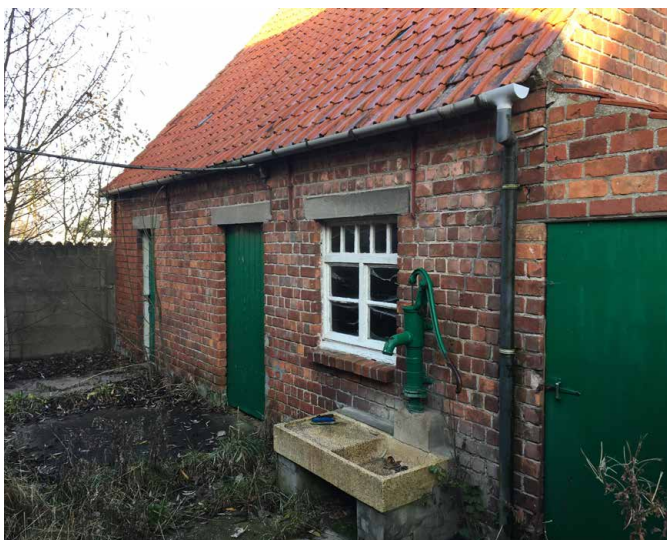
Figuur 11: Zicht op zone A vanuit het zuiden (5)
