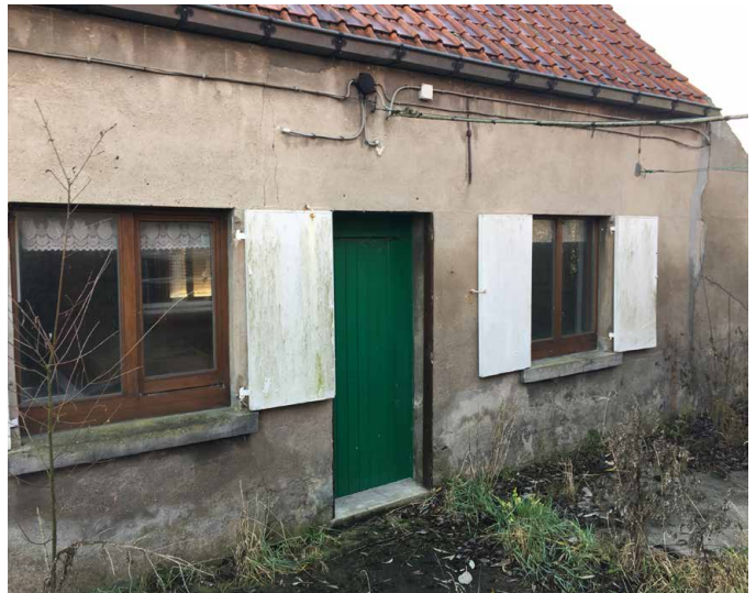
Figuur 10: Zicht op zone A vanuit het zuiden (4)
