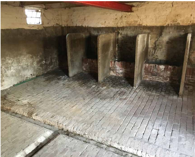
Figuur 9: Zicht op zone A vanuit het zuiden (3)
