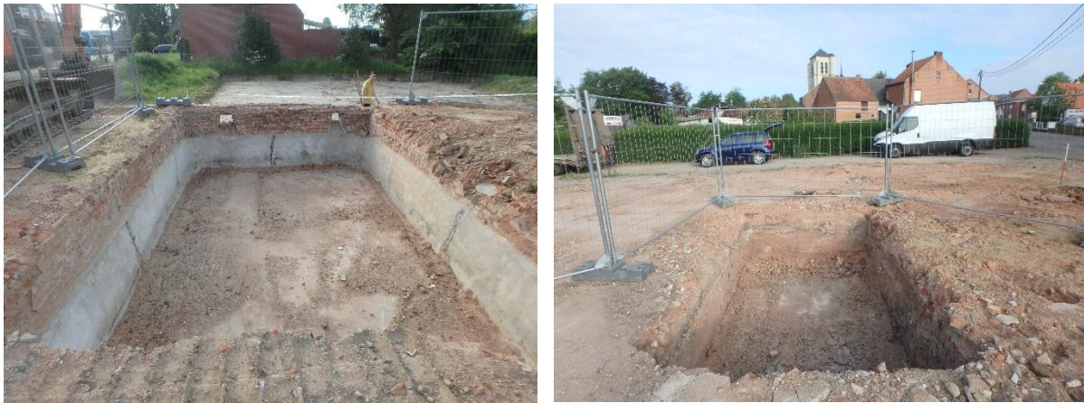
Figuur 14: Zicht op de meest oostelijke kelder (links) en de westelijke kelder (rechts).
