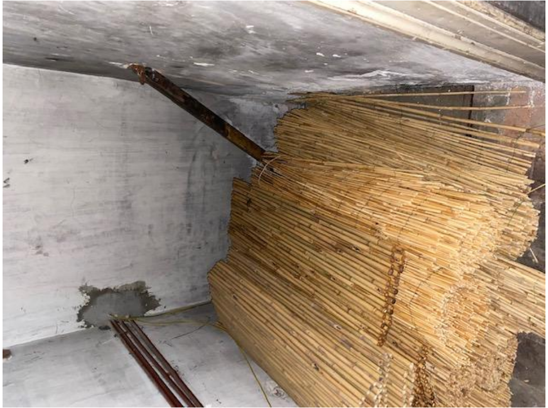
Afb. 40. Foto van de niet bereikbare kelder.
