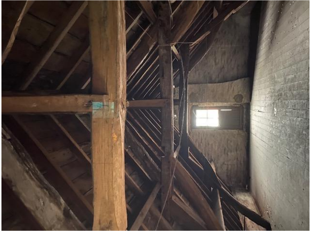
Afb. 42. Foto van de kapconstructie van het voorste deel van het gebouw.
