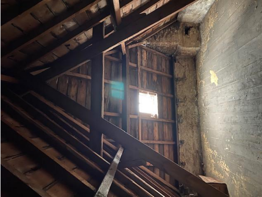
Afb. 41. Foto van de kapconstructie in de westelijke deel van het gebouw.
