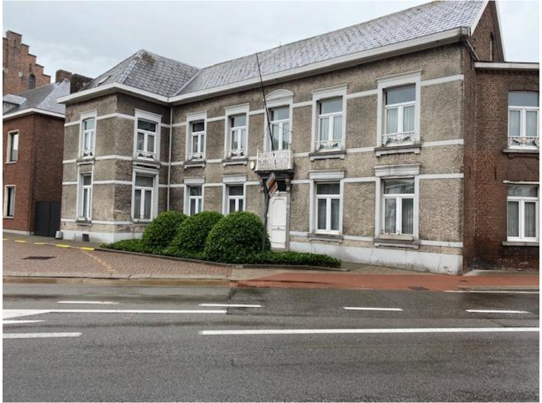
Afb. 33. Foto van de voorgevel.
