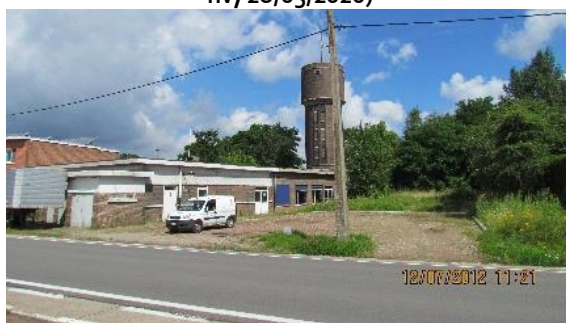
Foto 4: zicht op de watertoren, pompstation en voormalige locatie van het woonhuis aan de Slijkenhoefstraat (initiatiefnemer, 2012)
