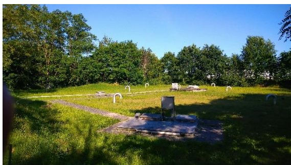
Foto 1 : zicht op de bestaande ondergrondse reinwaterkelders (ABO nv, 28/05/2020)
