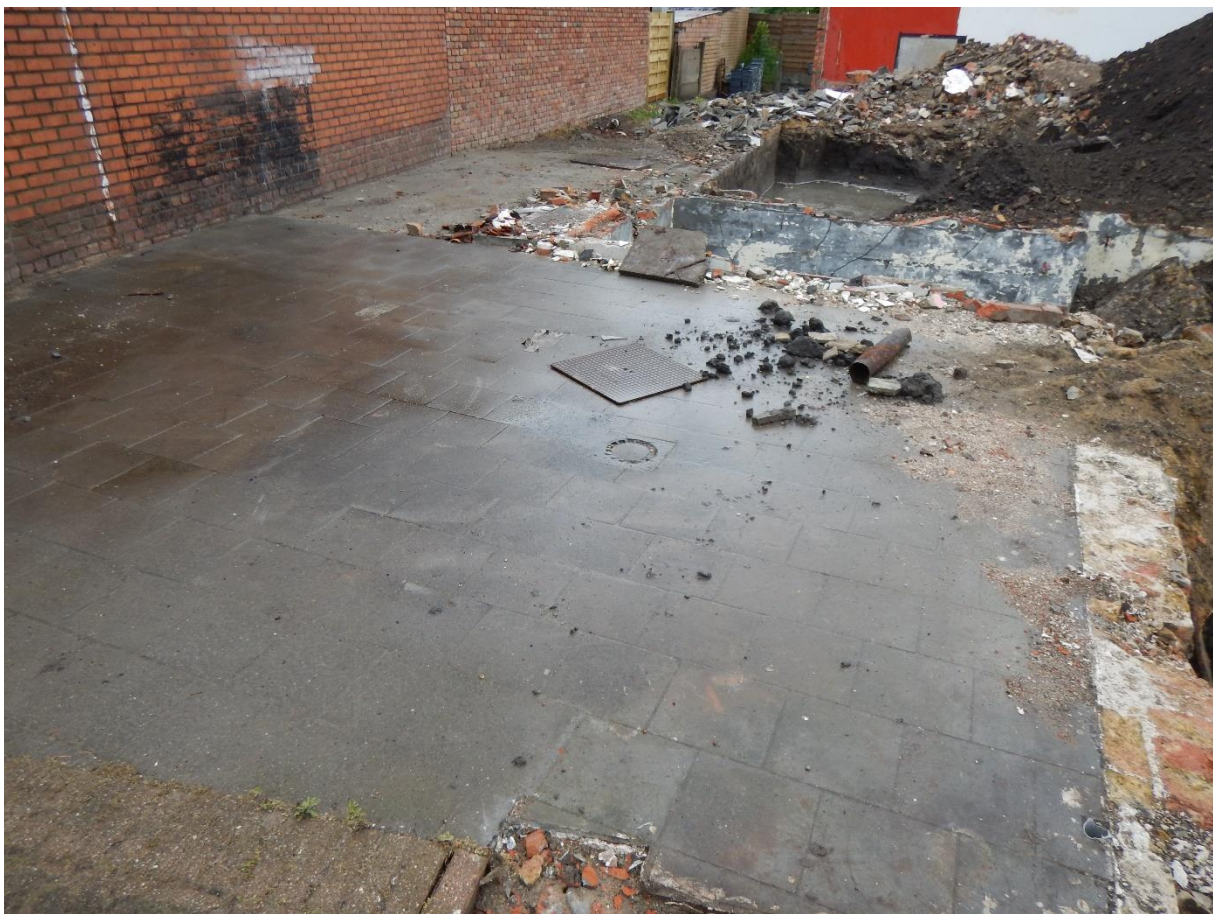
Figuur 6: fotografisch zicht op het noordelijk deel van het projectgebied met de ingekokerde beek en septische put
