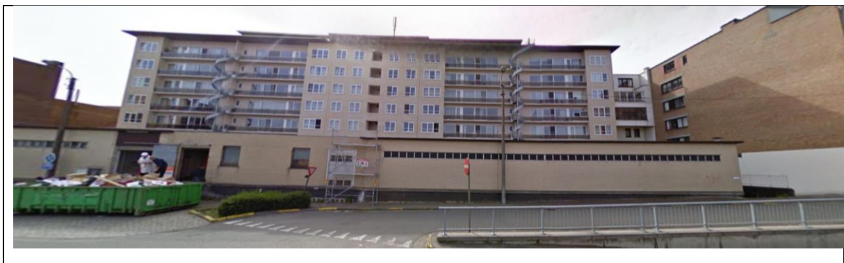
Figuur 6: Bestaande toestand ter hoogte van het studiegebied (zicht uit het noorden) (bron: google Street view 2016). In de voorgrond is de af te breken laagbouw langs de Vrijdomkaai te zien. In de achtergrond, de te behouden appartementen.
