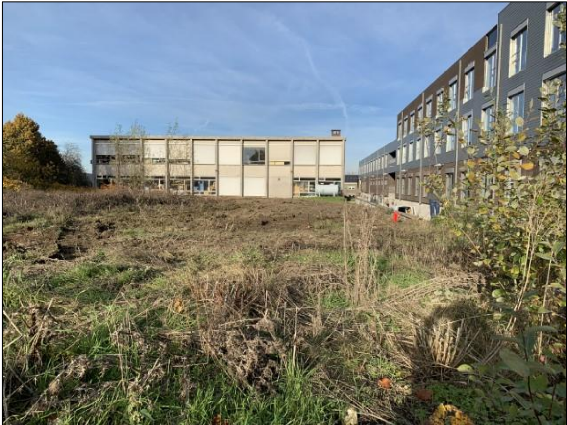
Figuur 9: Zicht ter hoogte van het centrale gedeelte (Bron: opdrachtgever).
