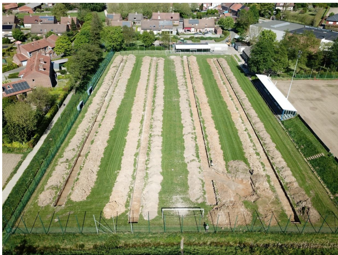
Figuur 16: Droneopname van het onderzoeksgebied vanuit het zuidwesten.
