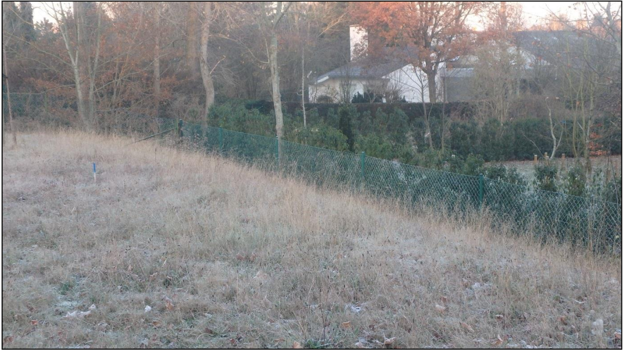
Figuur 27: Foto van boorpunt 3 (blauw paaltje). De tuin naast het talud is duidelijk lagergelegen (Foto door Erik Verbeke, 05/12/2016).
