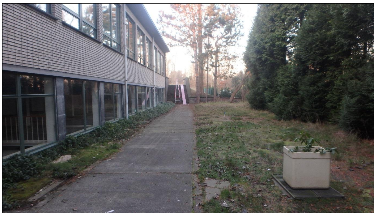
Figuur 26: Foto van de omgeving van boorpunt 2 met het pad links. De nutsvoorzieningen zijn, met uitzondering van het rooster onder de bloembak, niet zichtbaar omdat ze overgroeid zijn met gras. Op de achtergrond is de trap naar het talud en de talud zelf te zien waarop boorpunt 3 werd geplaatst (Foto door Erik Verbeke, 05/12/2016).
