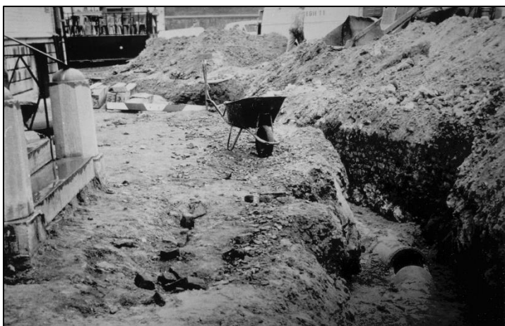
Afb. 31: zicht op een rioleringsleuf van 1934-1935 tijdens de werken in het centrum van de stad. In de sleufwand is nog een bewaard muursegment herkenbaar (SAT).
