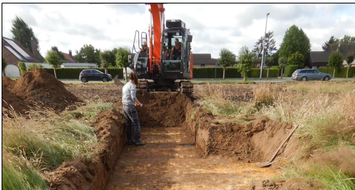
Figuur 4 Aanleg en opschaven van de proefsleuven.
