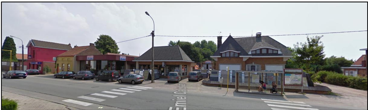
Figuur 3 Zicht vanuit de het noorden op de gebouwen langsheen de Assenedesteenweg (bron: https://www.google.com/maps ).
