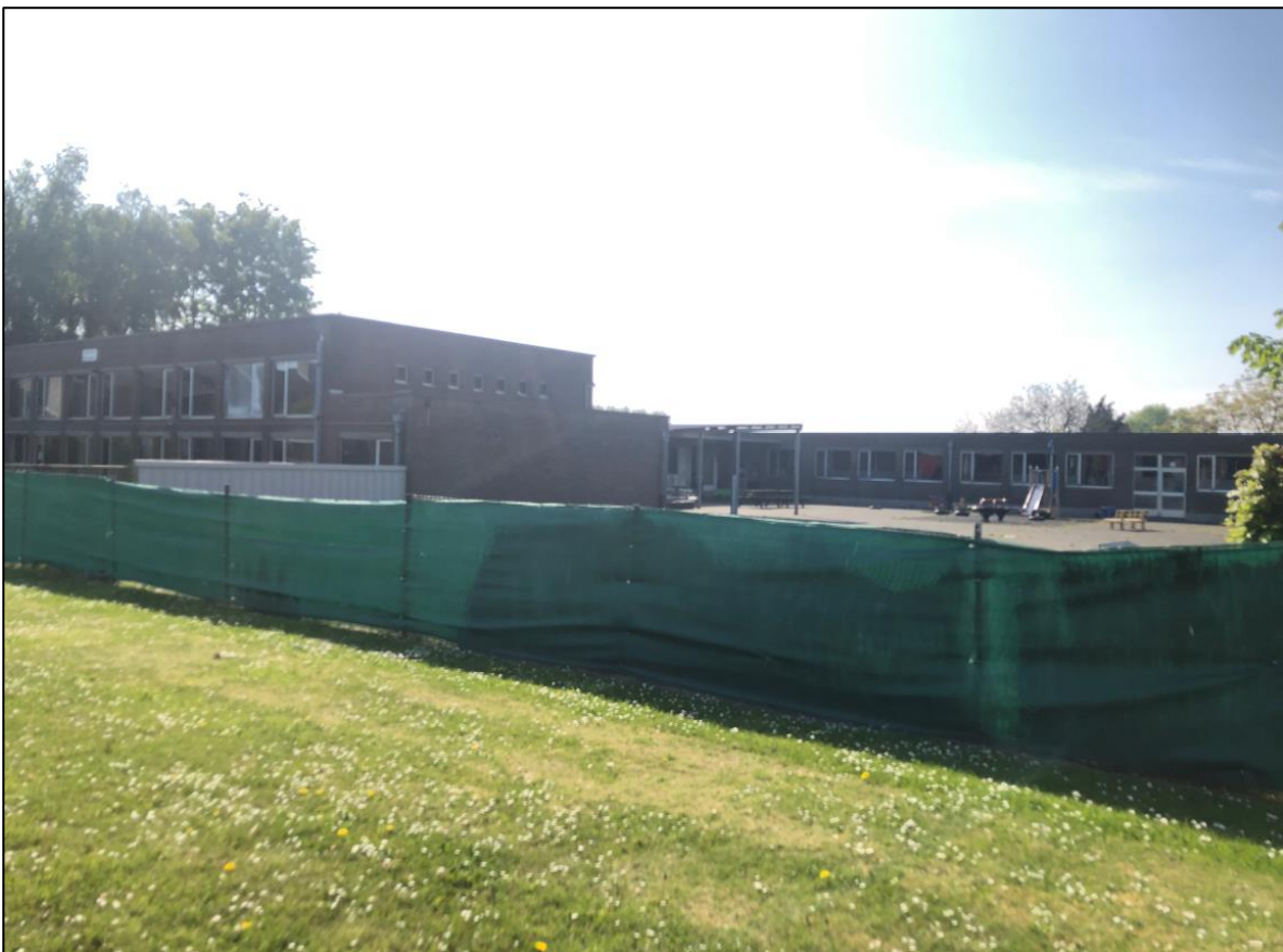
Figuur 11: Bestaande toestand (Bron: opdrachtgever).
