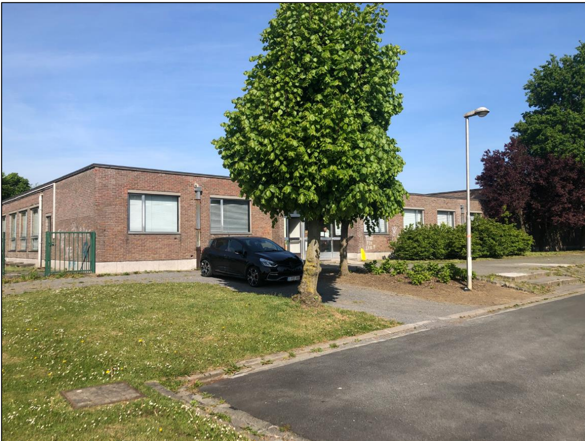
Figuur 7: Bestaande toestand (Bron: opdrachtgever).
