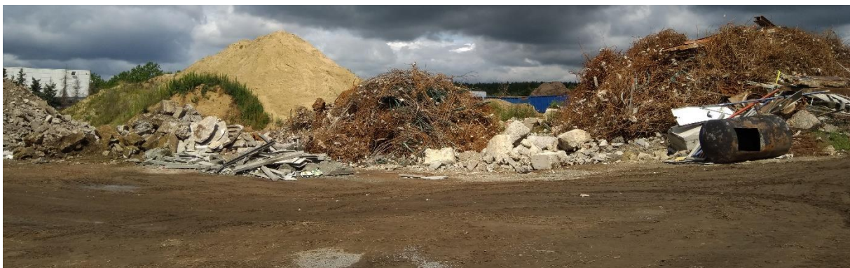
Figuur 5: Enkele van de puinhopen op het terrein. (Bron: Opdrachtgever 2020).
