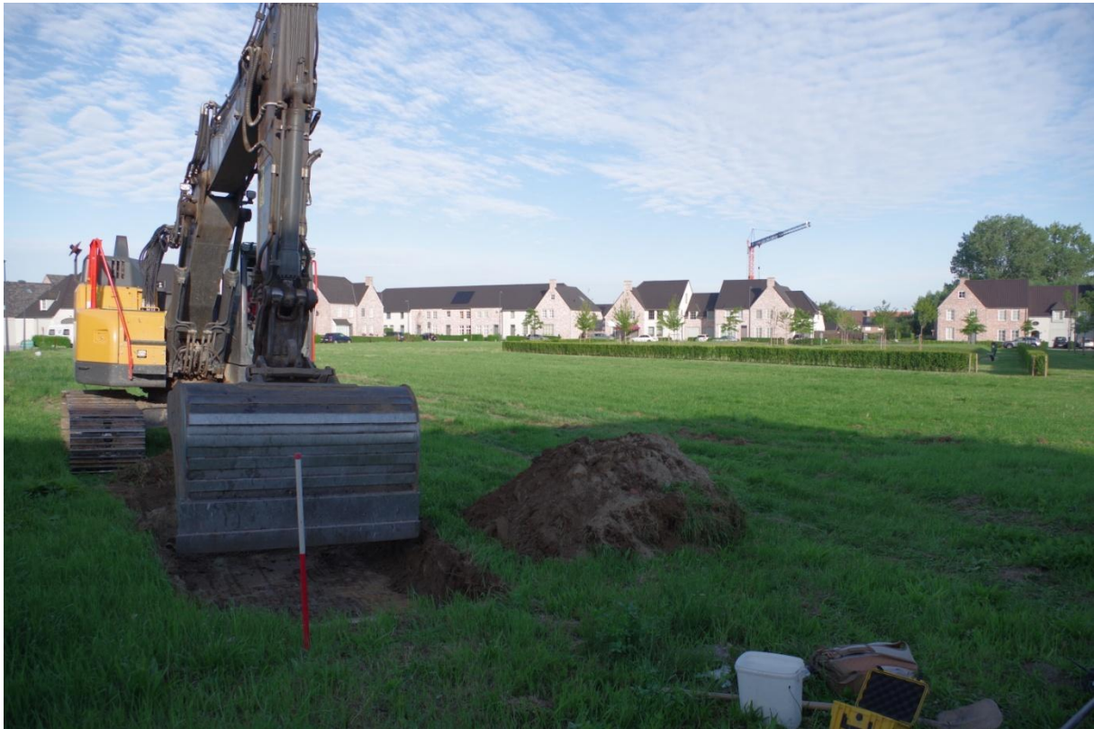
Figuur 3 Zicht op het terrein voor de aanvang van de werken.
