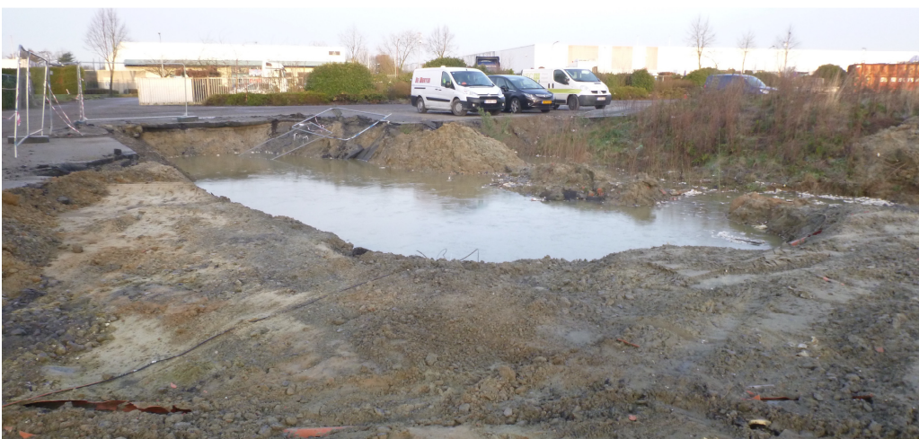
Afb. 18. De locatie van het kantoorruimte met ervoor de volledig verstoorte bodem ter hoogte van de verdiepte losplaats.
