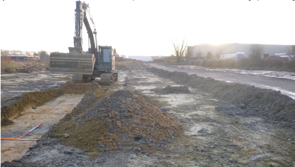
Afb. 17. Zicht op de afgravingen ter plaatse van de verdiepte losplaatsen, in relatie tot de circulatieweg (rechts).
