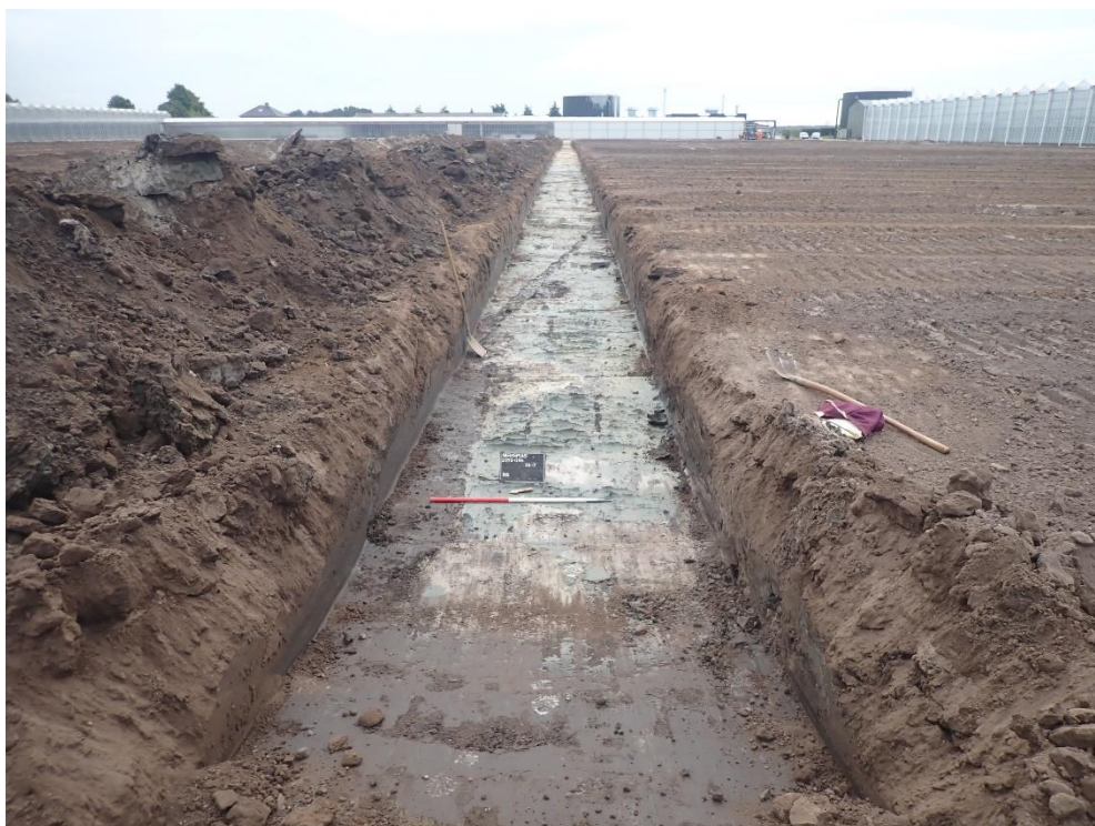
Figuur 24: Vlakfoto van sleuf 8 met zicht op enkele van de recente verstoringen (© J. Verrijckt Bvba)
