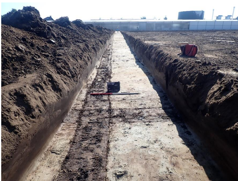
Figuur 23: Vlakfoto van sleuf 5 met zicht op enkele van de recente verstoringen (© J. Verrijckt Bvba)
