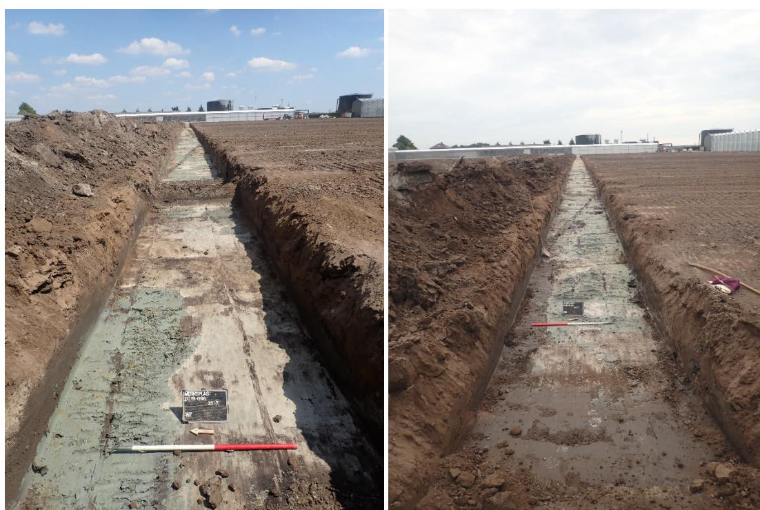
Figuur 10: Overzichtsfoto van sleuf 7 (links) en 8 (rechts) (© J. Verrijckt Bvba)
