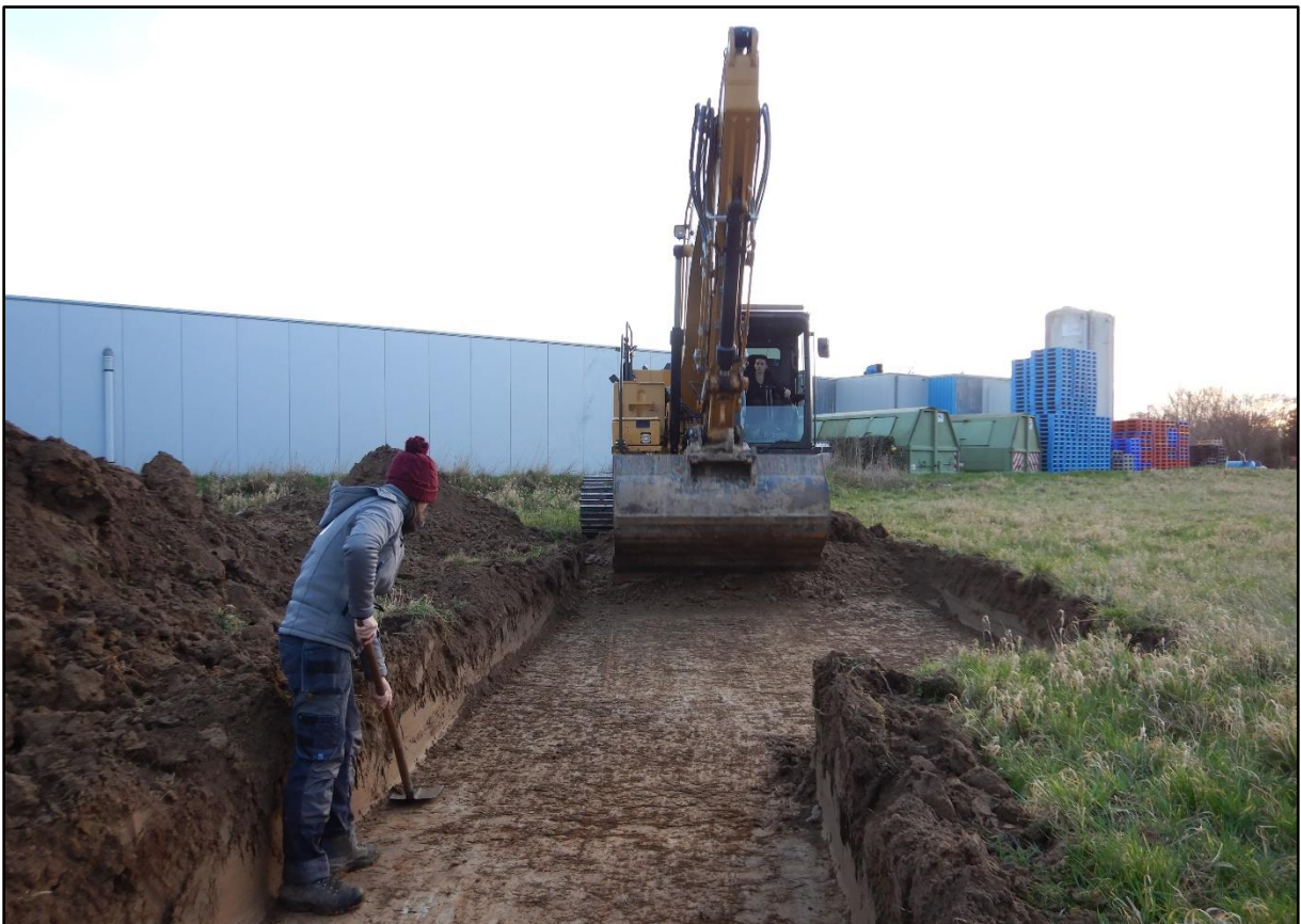
Figuur 4 Aanleg en opschaven van de proefsleuven.
