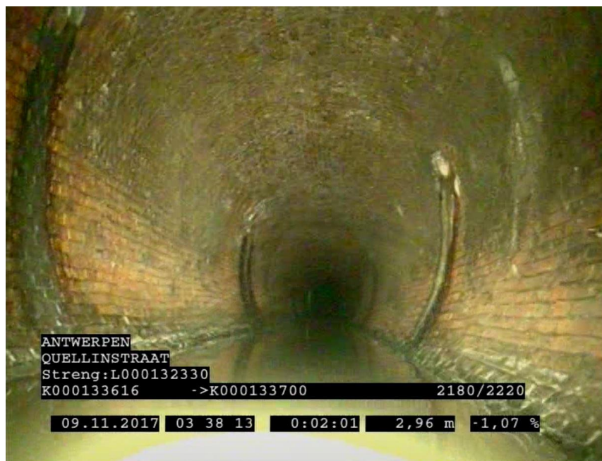
Figuur 8: Foto van de bestaande riolering binnen het gewelf (Initiatiefnemer 2020).
