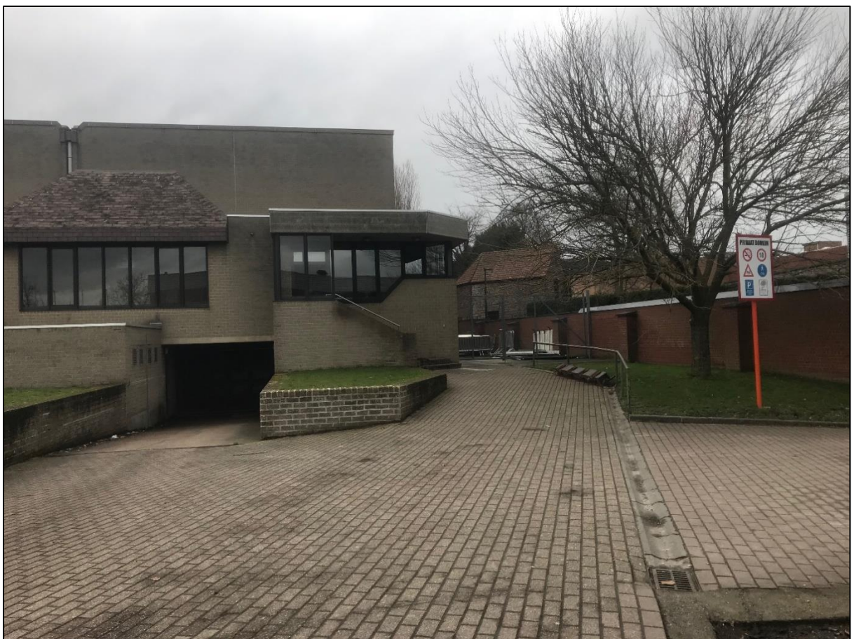
Figuur 8: Bestaande toestand (Bron: opdrachtgever).
