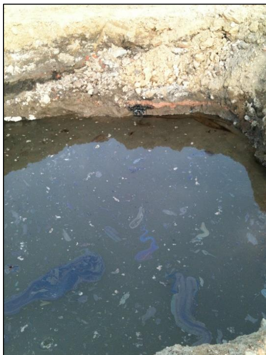
Figuur 24: Teervlekken bij saneringswerken in de Cadixwijk (Abo nv, 2013)
